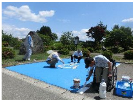
塗装作業の様子
